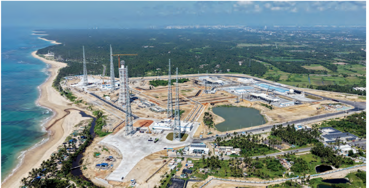
上图：2026年7月24日，从空中俯瞰海南商业航天发射场二期发射区。
