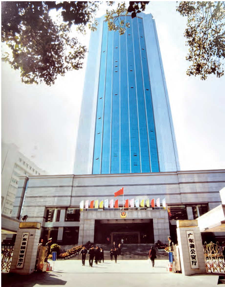
1997年落成的广东省公安厅指挥中心大楼。
