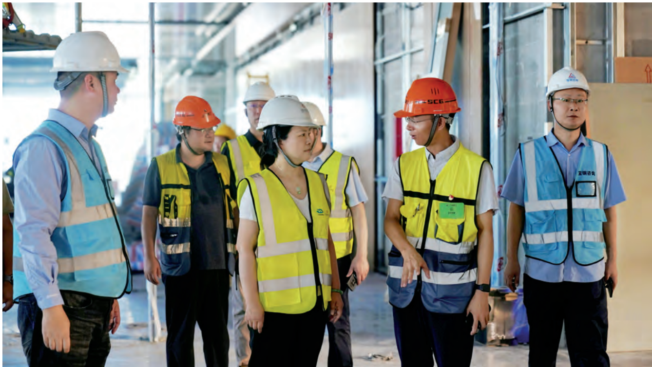
2025年许黎霞（前排中）在商合区建设现场检查。
