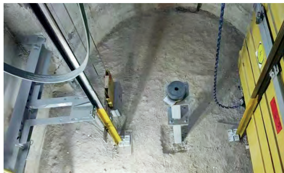
下图：按照必要的防护措施，电梯施工时应在底部安装缓冲器。 受访者供图
