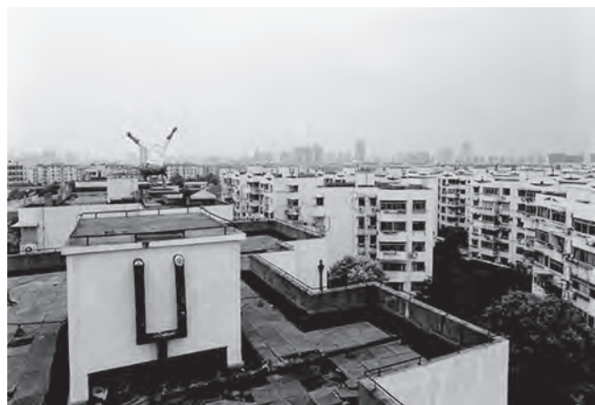
未进行屋顶改造时的新村。摄影/鸟头
