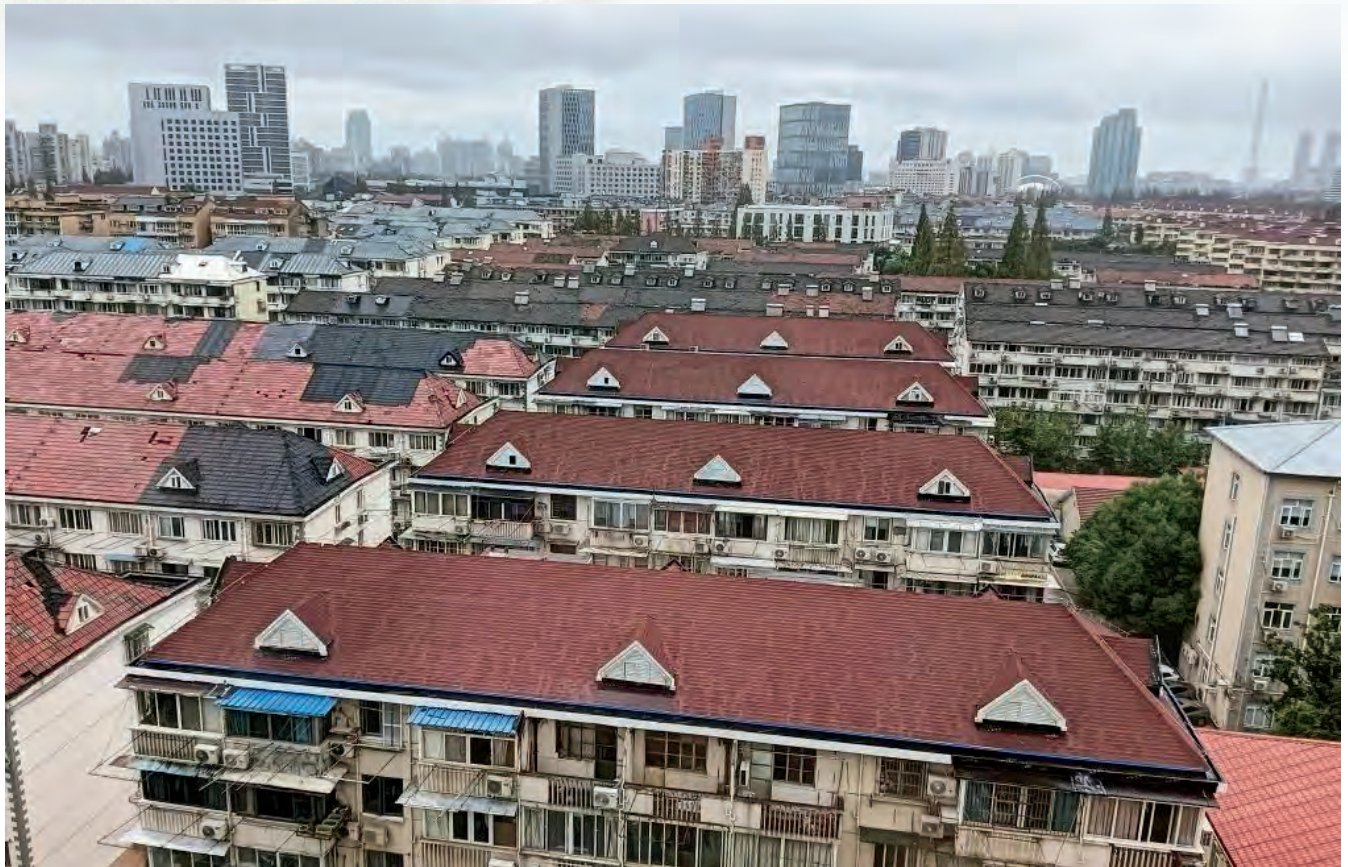
四平路街道和所属锦西路30弄居民区出动应急抢险队伍，对被前阵子“双台风”吹坏的小区屋顶及时清理修复。
