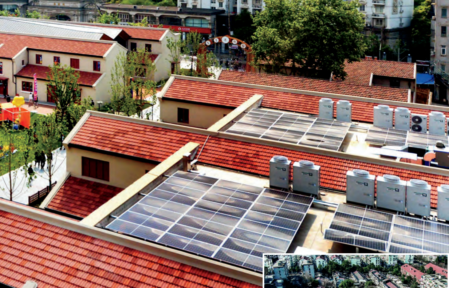
焕然一新的 228 街坊全景。
