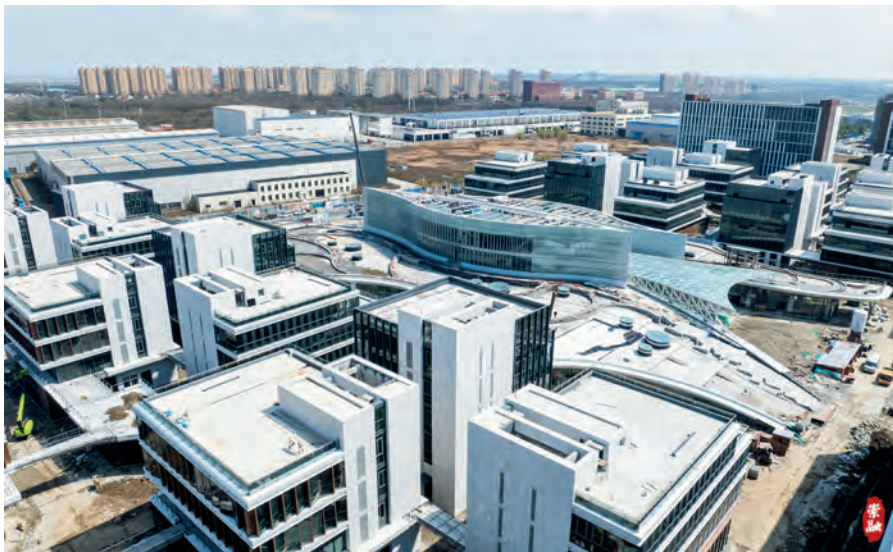
长兴海洋装备基地二期建设。摄影/吴雄
