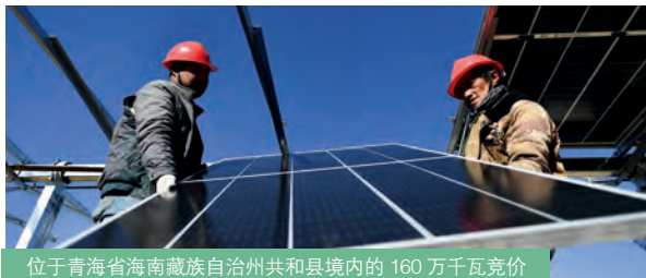
位于青海省海南藏族自治州共和县境内的 160 万千瓦竞价光伏项目正在加紧施工。
