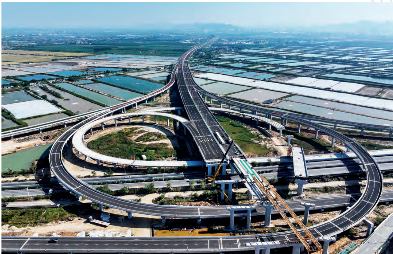
2023年12月8日拍摄的广东鹤港高速高栏港枢纽。
