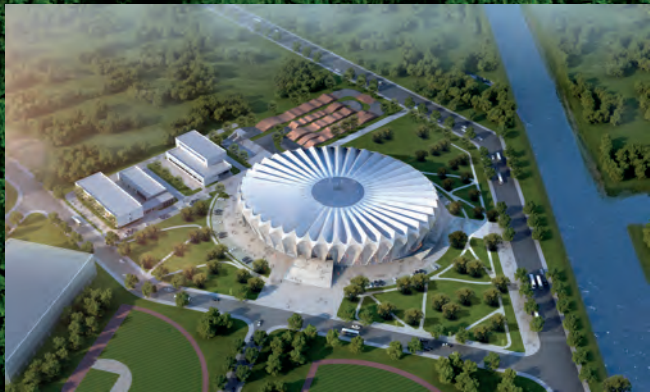
上海自行车馆位于崇明区陈家镇崇明体育训练基地北侧，集大赛、训练等功能为一体。
