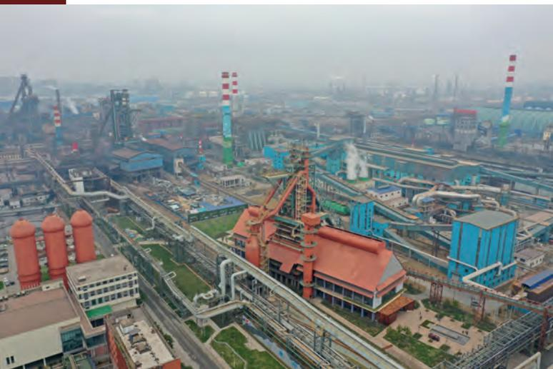
的富氢碳循环氧气高炉，实现了固体燃料消耗降低达30%，碳减排超21%的阶段目标。外表陈旧的高炉则已经成为工厂3A级工业旅游景区的景点之一。
