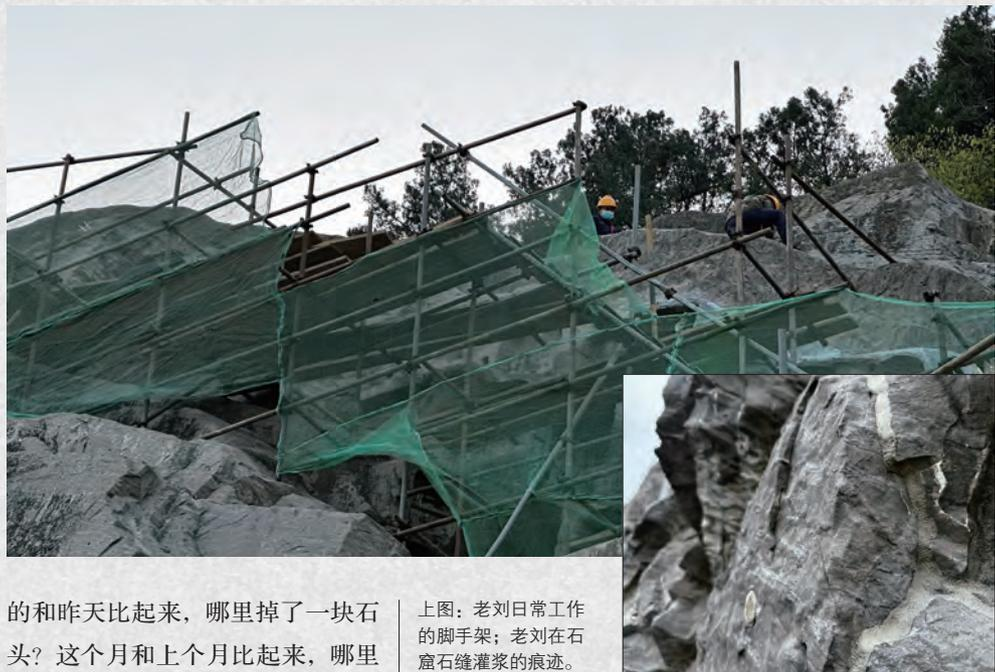
上图：老刘日常工作的脚手架；老刘在石窟石缝灌浆的痕迹。
