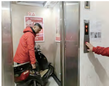
左图：2021年10月，长华绿苑小区成为杨浦区首批“新基建试点小区”，小区里的7台电梯都装上了电梯“阻车系统”。
