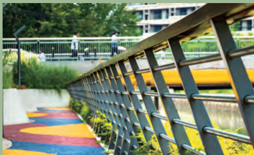
改造后的蒲汇塘桥。
