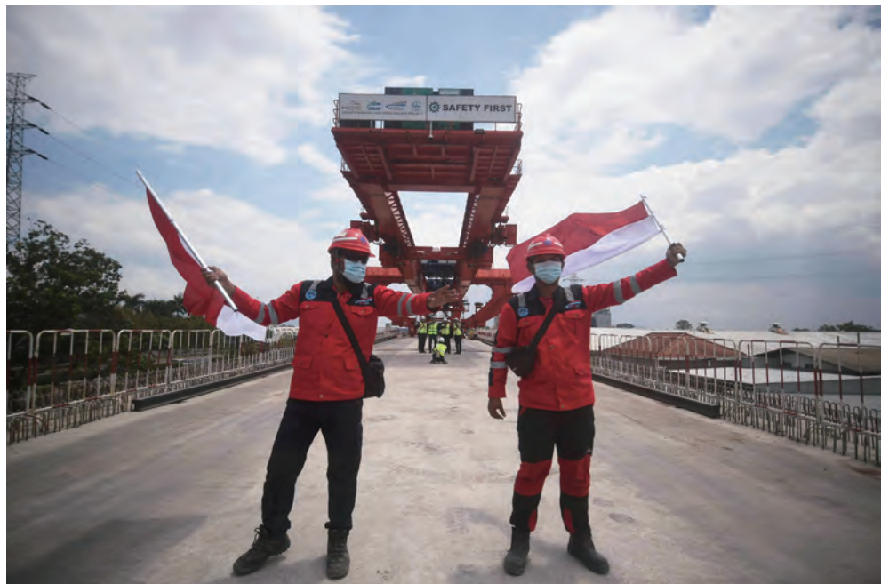
上图:2020年9月3日,印尼雅万高铁4号梁场进行架梁作业。
