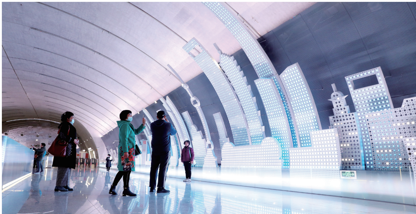
上海地铁 15 号线吴中路站站厅采用净跨达到 21.6 米的预制大跨叠合拱型结构，是上海地铁首个无柱大空间站台大厅，带给乘客一种广阔的空间感。
