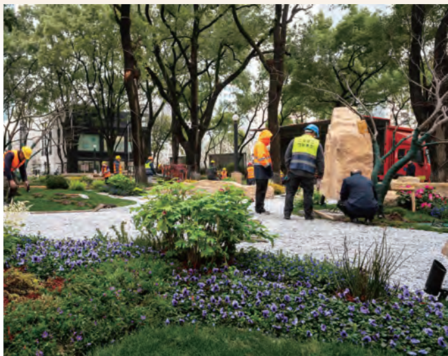
室外花园修缮施工。摄影/沈琳
