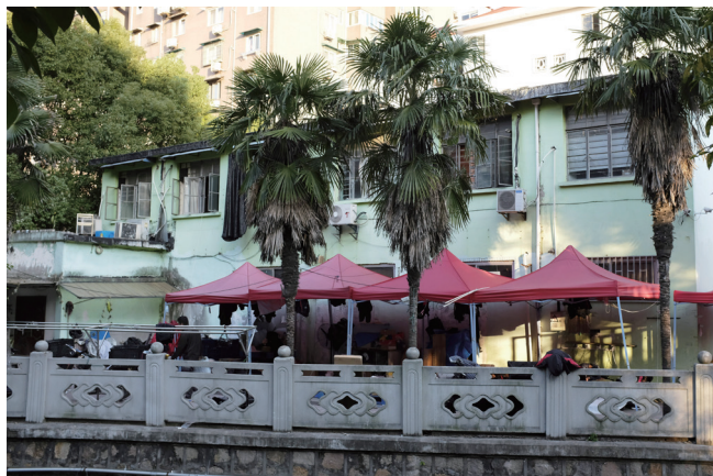
旧房属于企业，街道与企业合力推进改造。图片提供 / “热气建筑”
