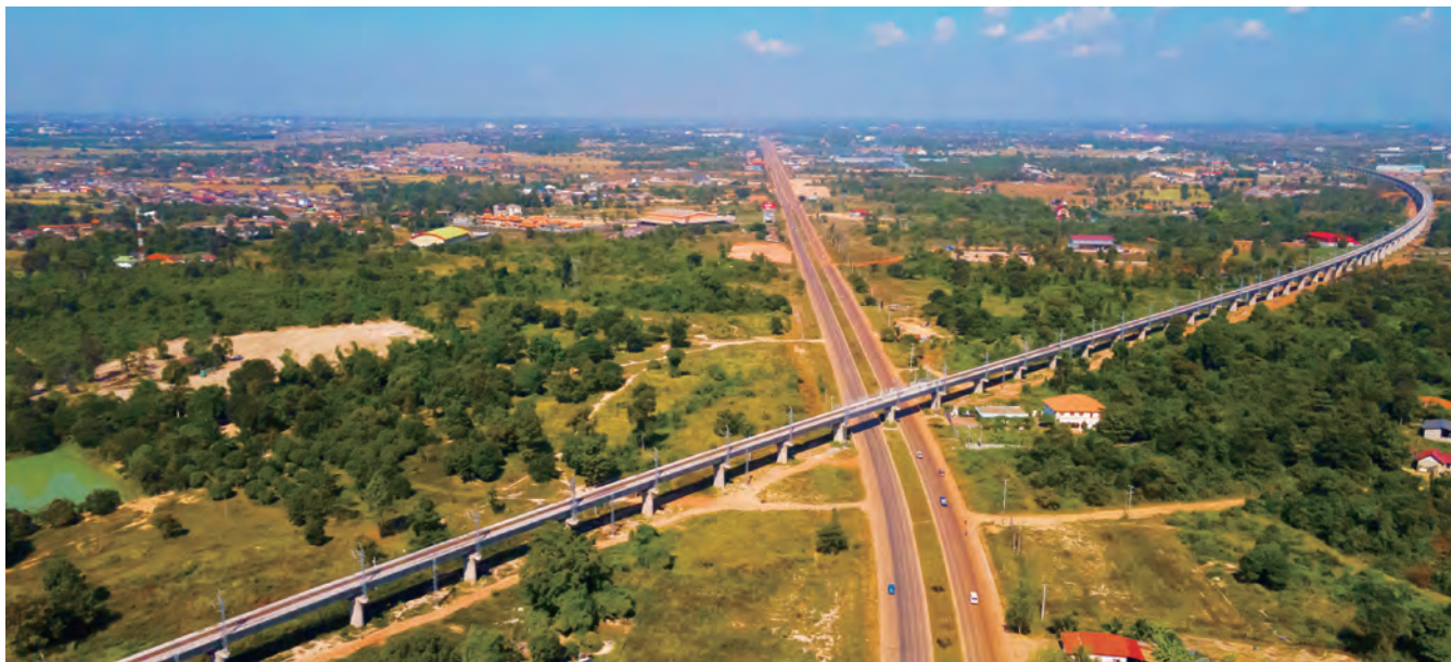
2021年11月21日在老挝首都万象郊区拍摄的中老铁路。
