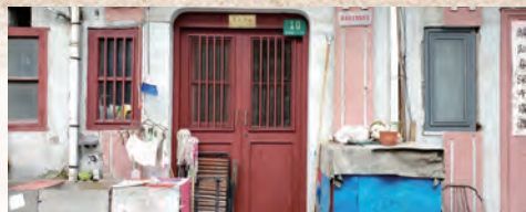
▲ 临青路116弄（临青坊）10号现状。
