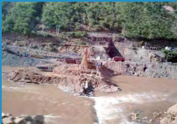
2017年，戛洒江水电站施工现场。
