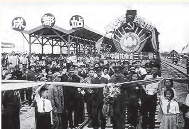
新中国第一条铁路——成渝铁路 1952年7月1日通车。
