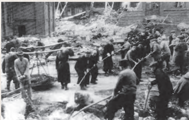
1950年的“二六轰炸”中，杨树浦电厂等被炸，市区供电受到严重影响。图为工人在清理现场。
