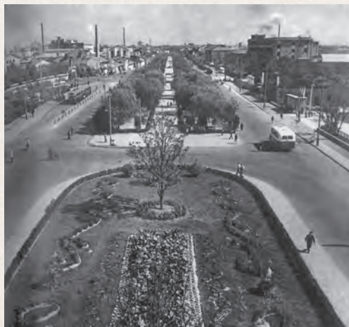
1954年10月，肇嘉浜改造工程动工，昔日“龙须沟”成为一条集交通、排水、绿化等功能于一体的林荫大道。
