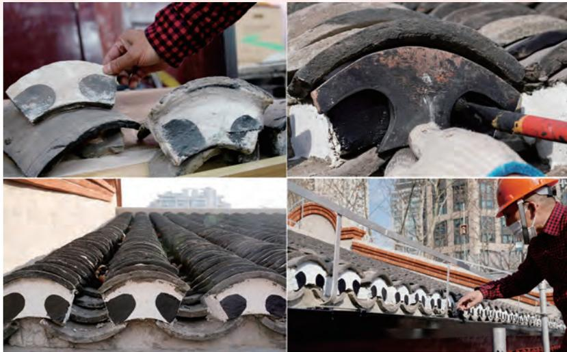
中共一大会址纪念馆建筑的瓦当独具特色：白底上有两个黑圈，被称为“熊猫眼”。这张拼版照片左上为工人拆下来的旧瓦当；右上为工人用工具修缮旧瓦当；左下为已铺好的新瓦当；右下为已铺好的新瓦当。
