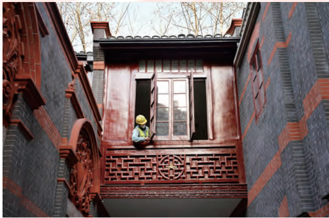
3月22日，工人在一大会议址修缮现场施工。
