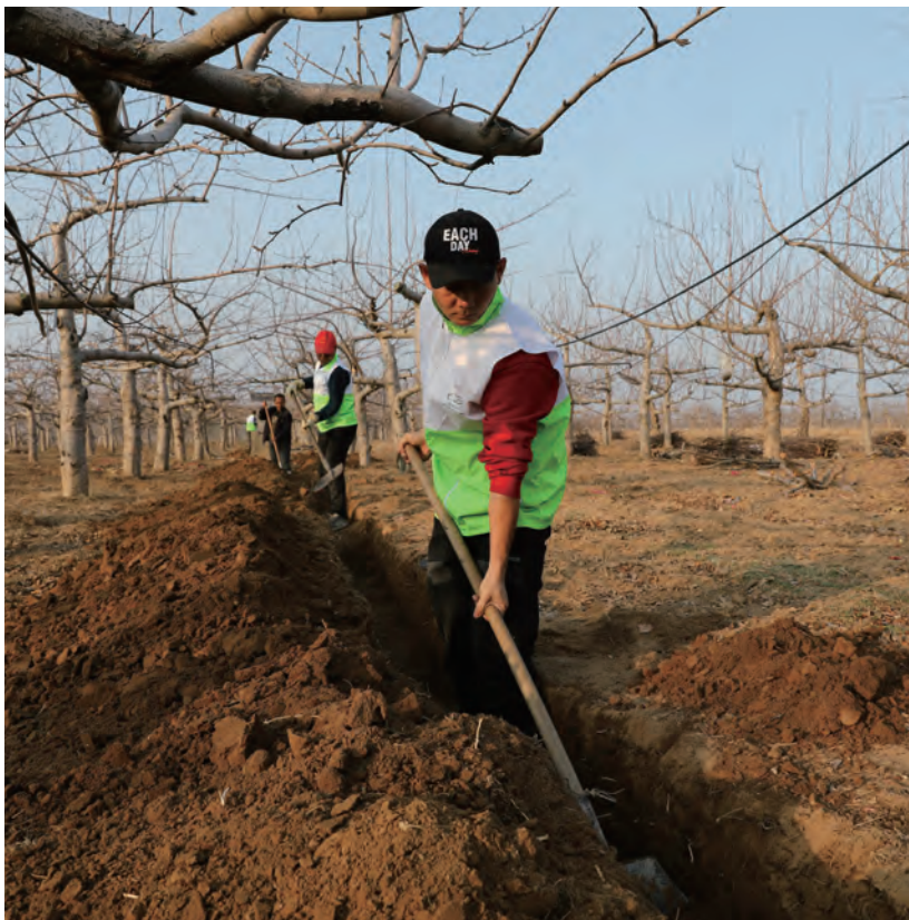
“绿动未来”平台带领志愿者为阁楼小学修建引水渠。
