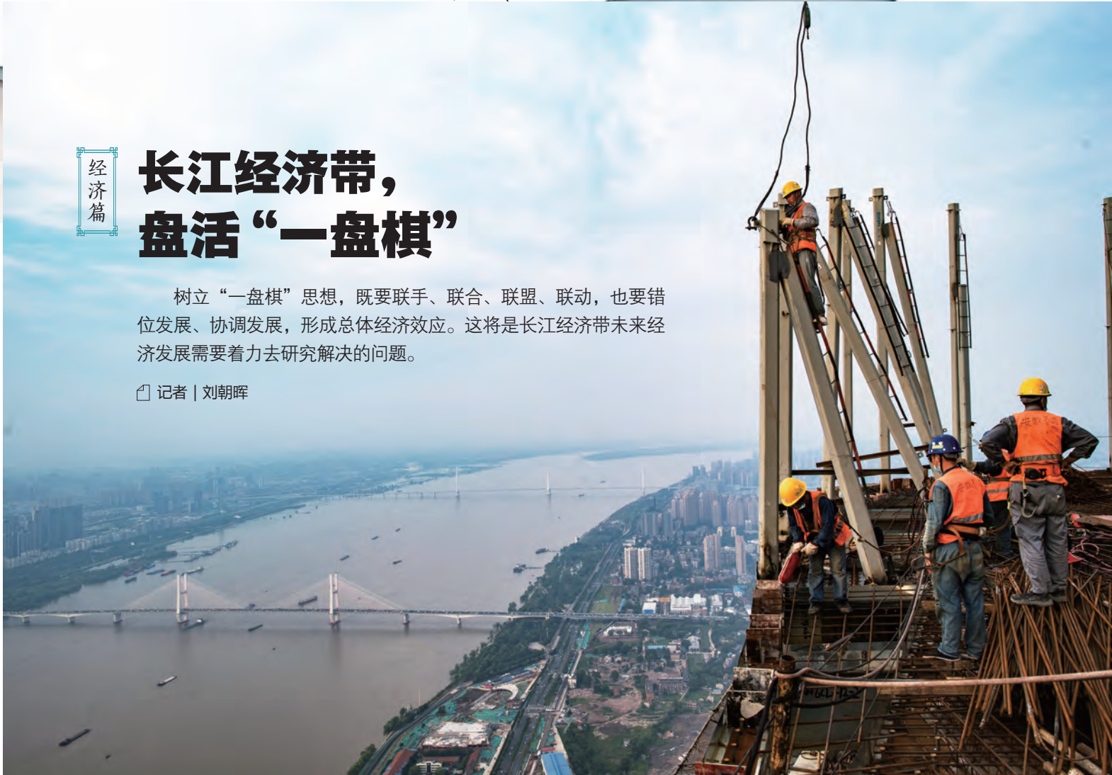
8月11日，在武汉绿地中心项目建设现场近500米的高空，来自中建三局二公司的工人熊明生（右）、张幸红冒着高温施工。
