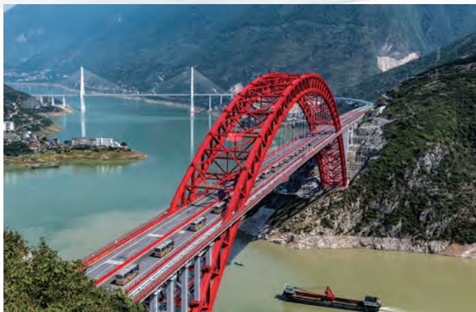
在湖北省秭归县拍摄的秭归长江大桥。
