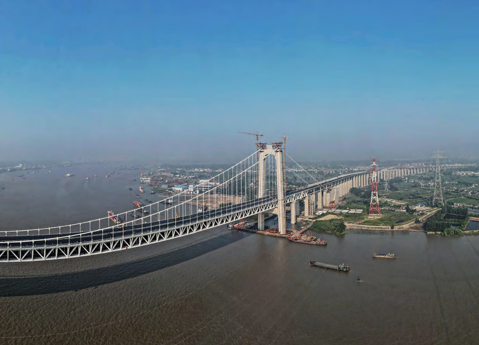
世界首座高速重载公铁两用悬索桥——五峰山长江大桥。
