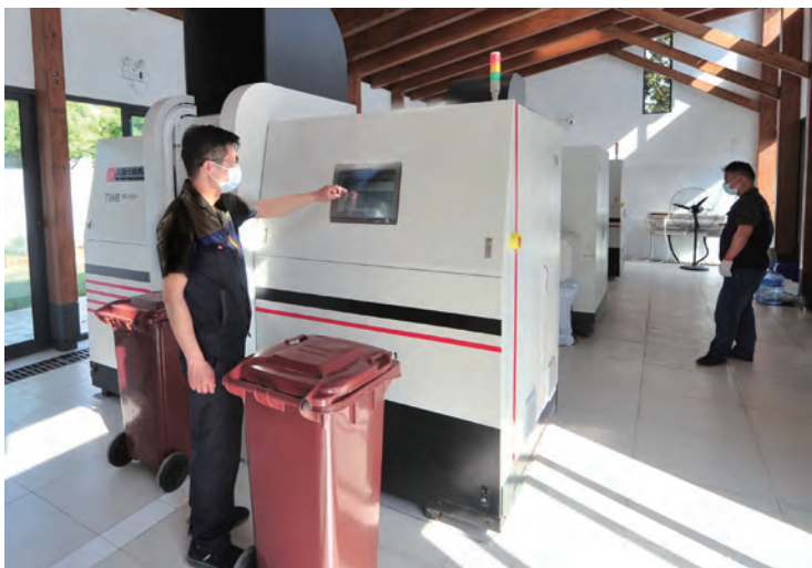
下图：虹梅街道“一区三点”湿垃圾回收处理模式的集中处理区，内设置4台分布式湿垃圾处理机，运用微生物处理技术分解辖区内产生的湿垃圾。
