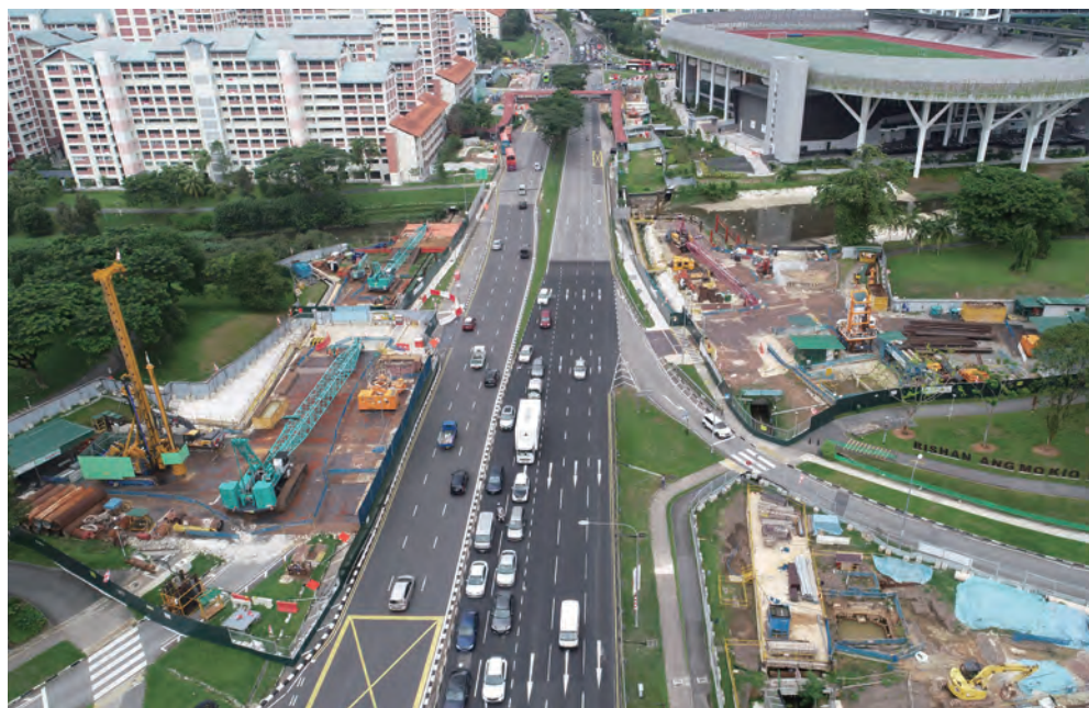
上图：新加坡南北交通廊道项目 N109A。
