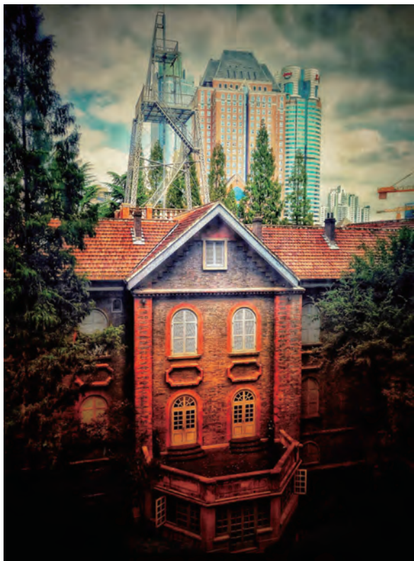
徐家汇观象台旧址。
