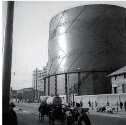
上海西藏路桥畔旧时英商建立的煤气储气罐
