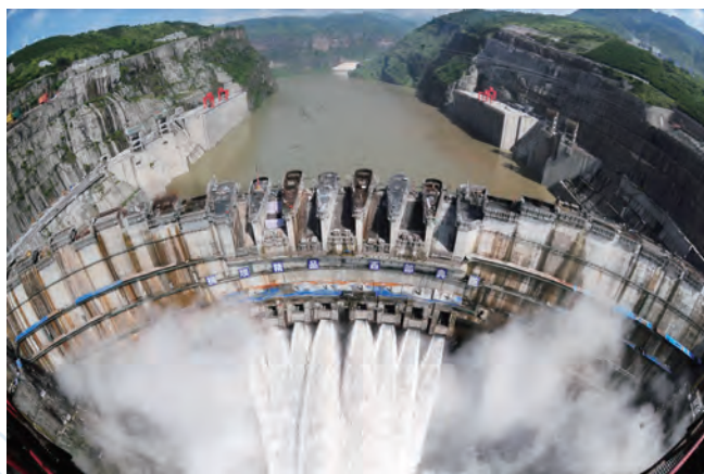
金沙江上最大水电站——溪洛渡水电站。
