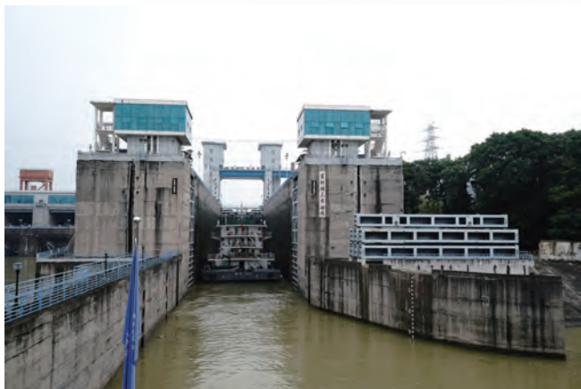
葛洲坝船闸。摄影 / 沈琳
