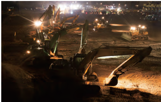
1月25日，雷神山医院工地。
