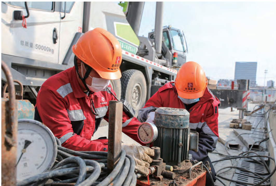
2月23日，合肥轨道交通4号线5标东二环路站工人们在施工。
