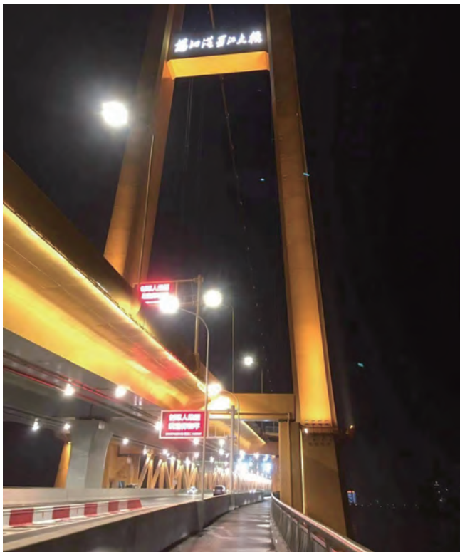
余毅拍摄的武汉杨泗港长江大桥。
