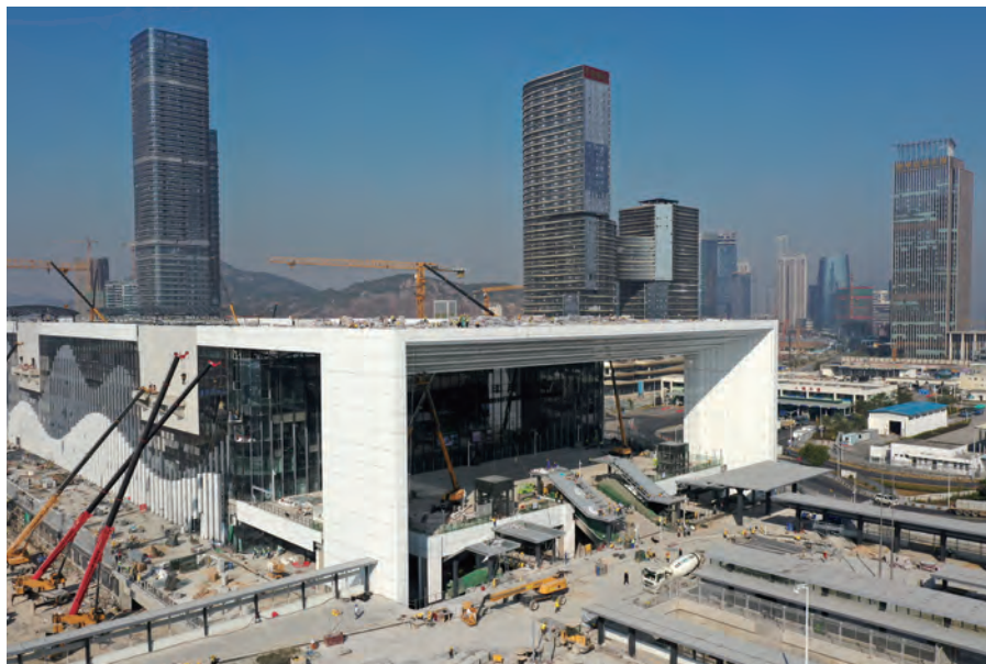
广东珠海横琴口岸及综合交通枢纽施工进度顺利，目前已基本具备通关条件。新横琴口岸将采用“合作查验、一次放行”的创新通关模式，设计日通关流量达 22.2 万人次。
