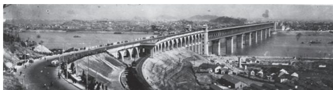
武汉长江大桥
