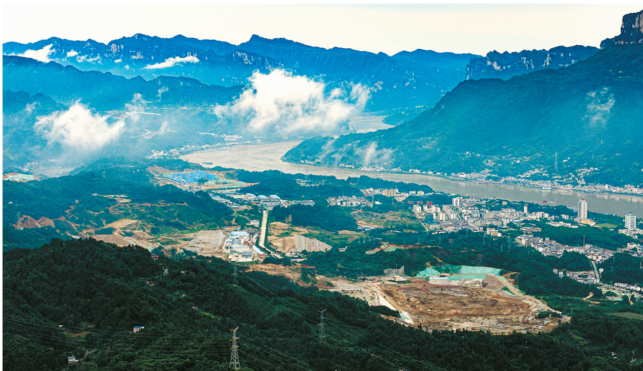
昨天拍摄的三峡水运新通道工程三峡枢纽新通道施工现场 新华社记者 肖艺九 摄
