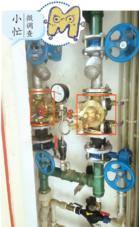
▲ 部分供水压力阀已更换
