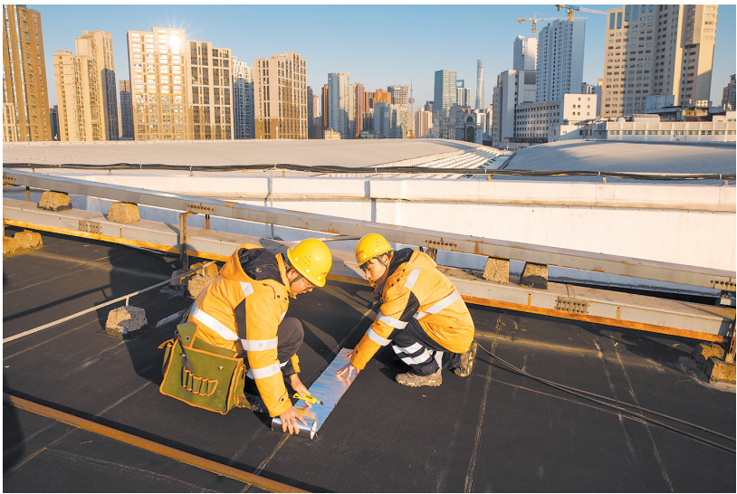
陈奕鑫(右)和同事在上海站候车室屋面,使用丁基胶带修补防水卷材破损处
