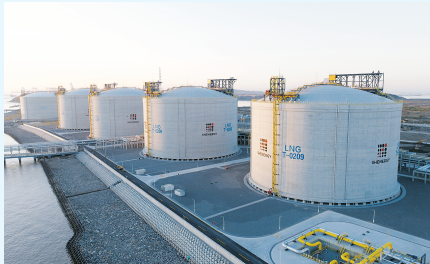
上海LNG站4座22万立方米的LNG储罐 本版图片 采访对象供图
