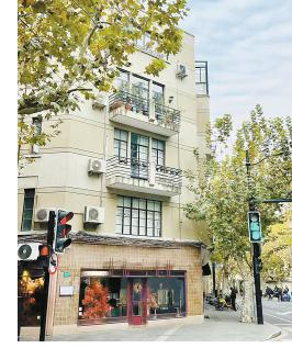
建于1936年，由建筑师拉比诺维奇设计，现代建筑风格的公寓住宅。建筑为五层混合结构，平面近似“L”形，顶端为构图中心，中间砌水泥方柱，转角为弧形。二层以上挑出阳台，设铸铁栏杆。两侧局部墙面凸出，平顶，素色水泥抹面外墙。
