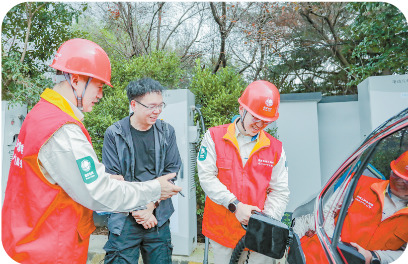
国网上海电力工作人员在三汇路充电站向用户介绍参与车网互动V2G反向送电享补贴的服务政策
