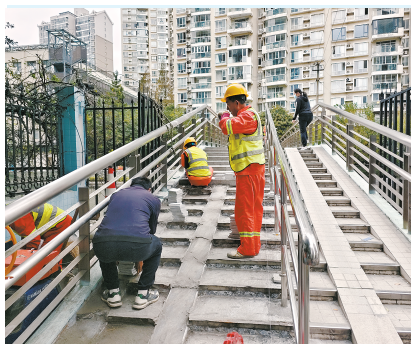
改造工程正在施工中 马蒋荣 摄
