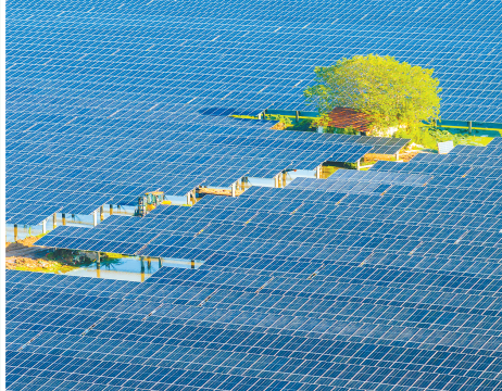
建设渔光互补光伏发电项目
