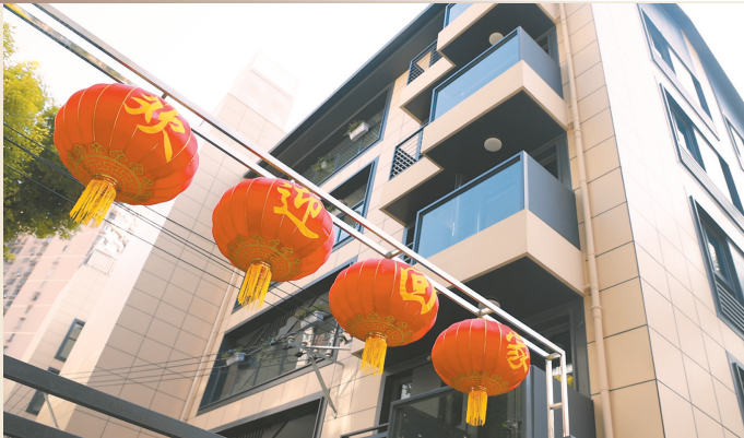
■ 原址改建后的普育东路101弄1—4号新楼外观时尚
